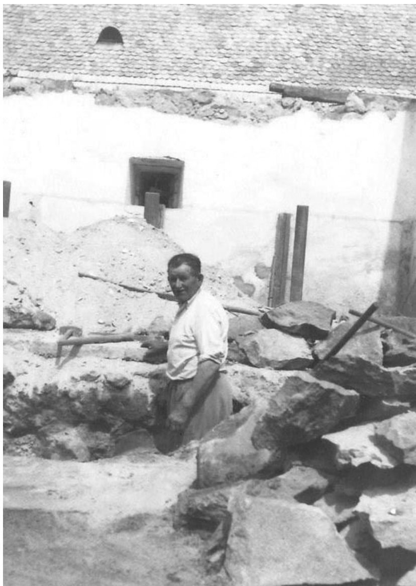
6. Ján Šimon pri prestavbe rodinného domu č. 62 v roku 1966. Fotoarchív Sone Kmeťovej.
