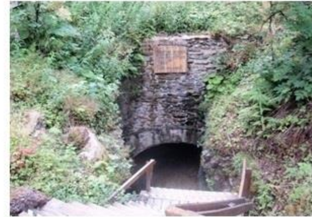
Vstup do tunela pri Slavošovciach - 2015
